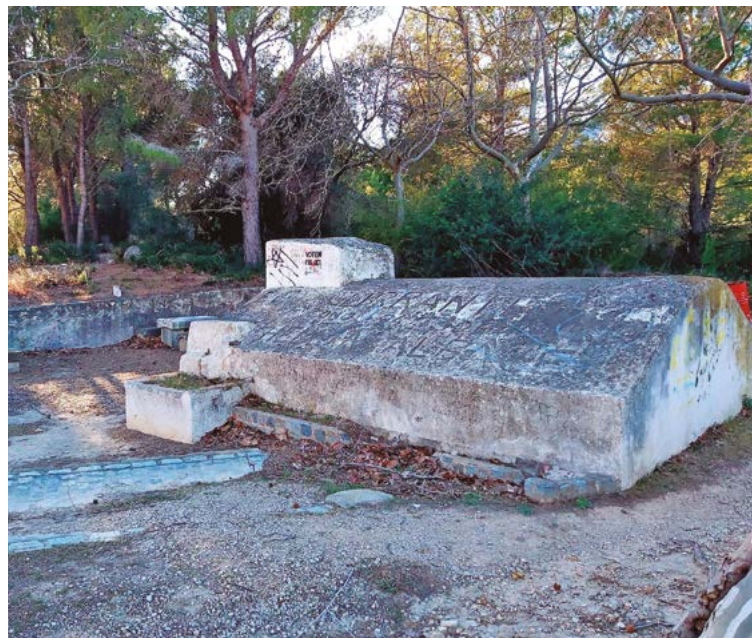
Cisterna del segon portazgo, construïda en temps de la guerra del Francès.
