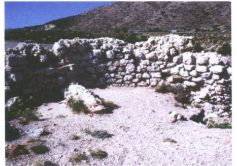
Vista de l'interior de la torre Autor: DGPC Data: agost / 1995
