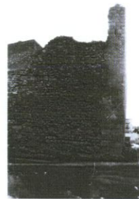
Detall dels murs amb una de les torres característiques.
