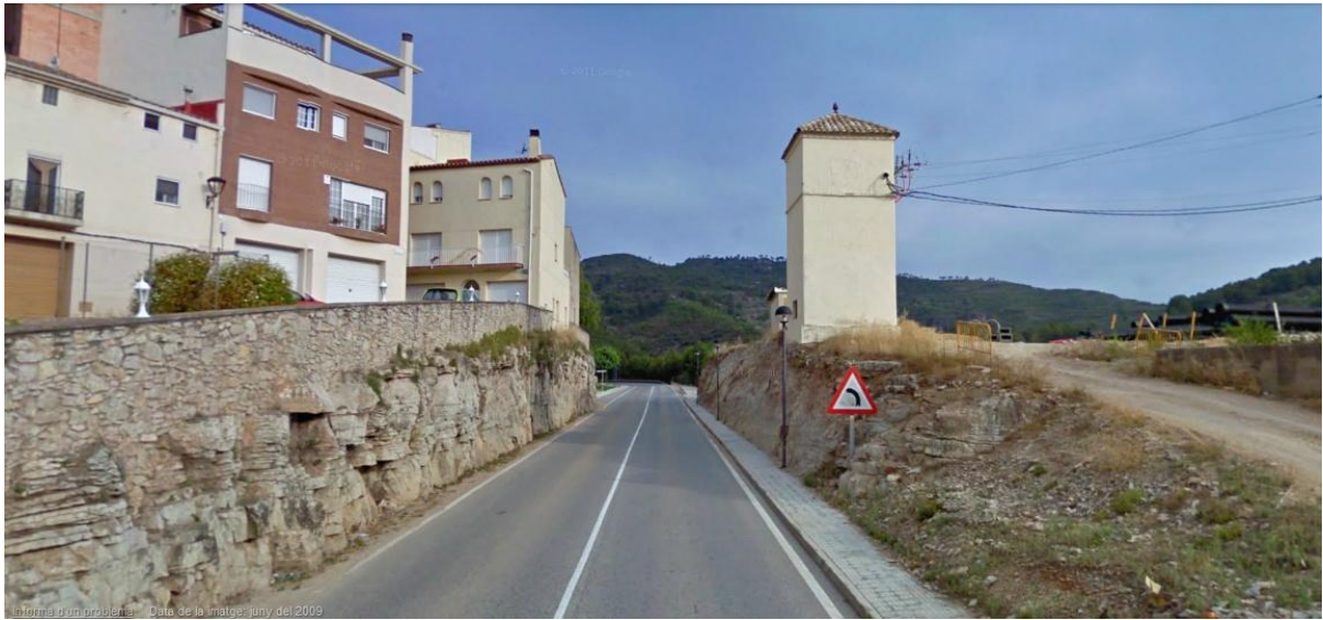
Imatge 3 Tall de la carretera C-44 al seu pas per Vandellòs
