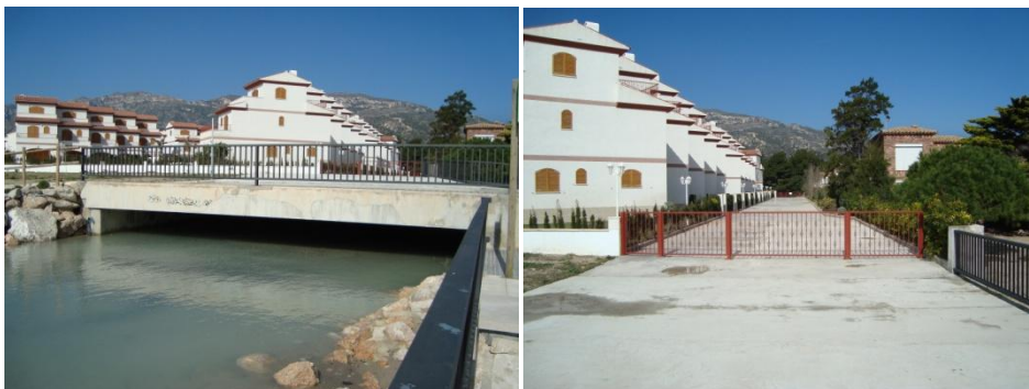
Figura 4. Desembocadura del barranc de la Porrassa cobert per vial d'accés a vivendes
