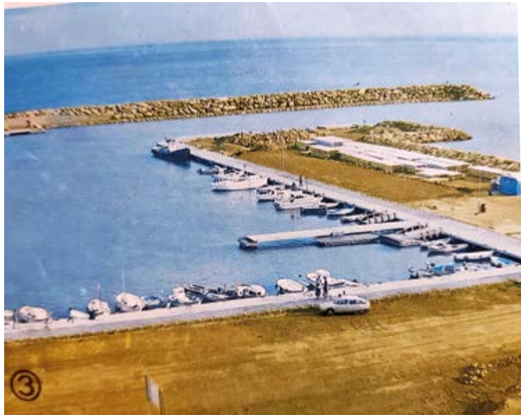
El port esportiu en construcció l'any 1983.
