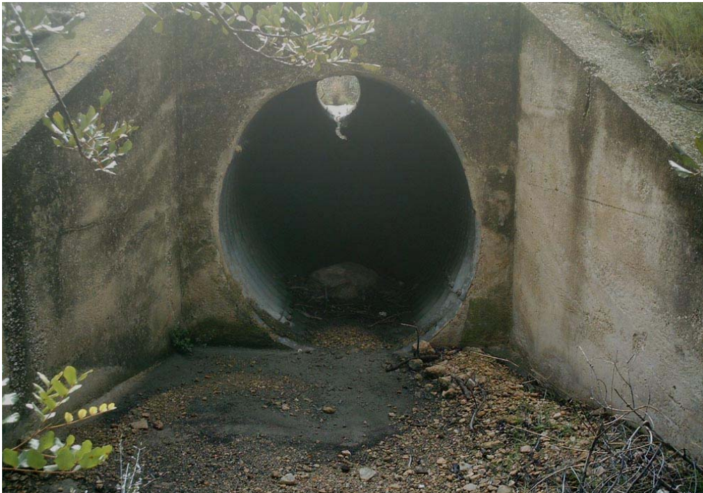
F1. Vista de l'obra de drenatge transversal sota la carretera Nacional N-340. Vista des d'aigües amunt cap aigües avall.
