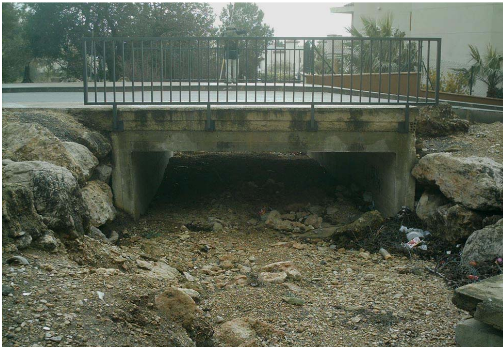
F7. Vista de l'obra de drenatge del barranc de la Porrassa sota el carrer "A. Poblat d'Hifrensa", des d'aigües amunt cap aigües avall.
