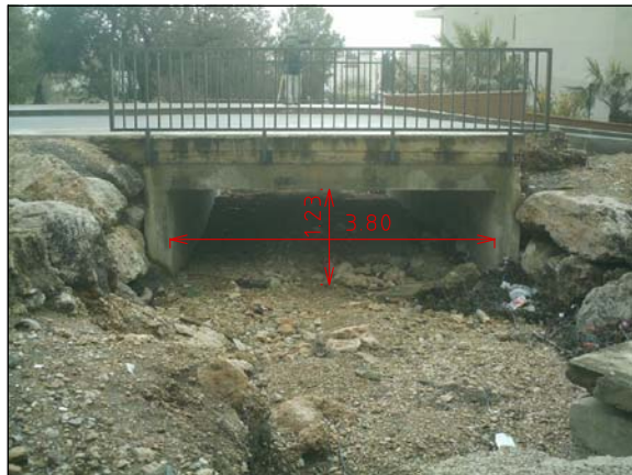
FOTO 5 CARRER DE LA PORRASSA ENTRADA
