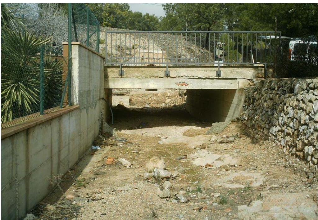
F8. Vista de l'obra de drenatge del barranc de la Porrassa sota el carrer "A. Poblat d'Hifrensa", des d'aigües avall cap aigües amunt.
