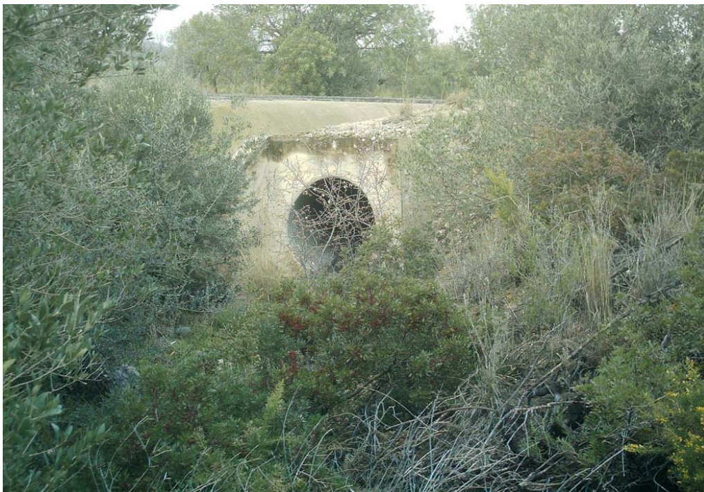
F2. Vista de l'obra de drenatge transversal sota la carretera Nacional N-340. Vista des d'aigües avall cap aigües amunt.
