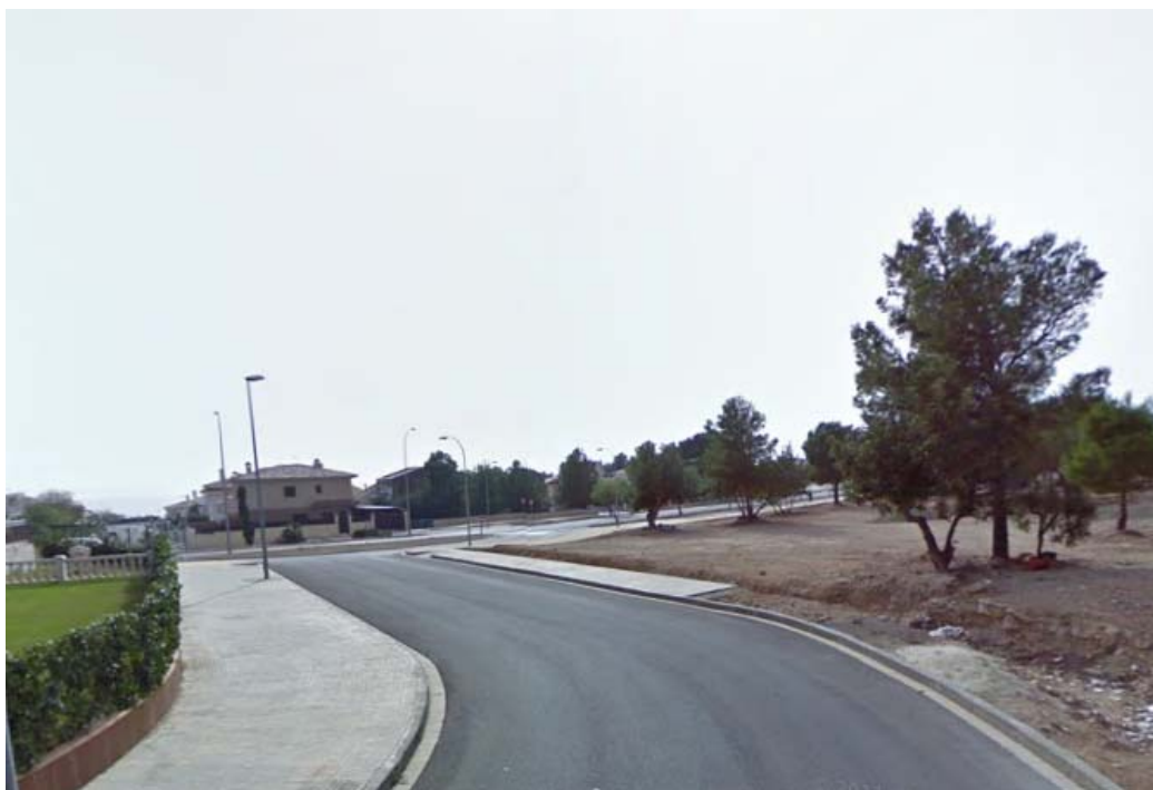
F10. Vista del canal de terres adjacent a la vorera costat muntanya del carrer A d'Hifrensa, que continua adjacent a la vorera costat muntanya de la Via Augusta .
