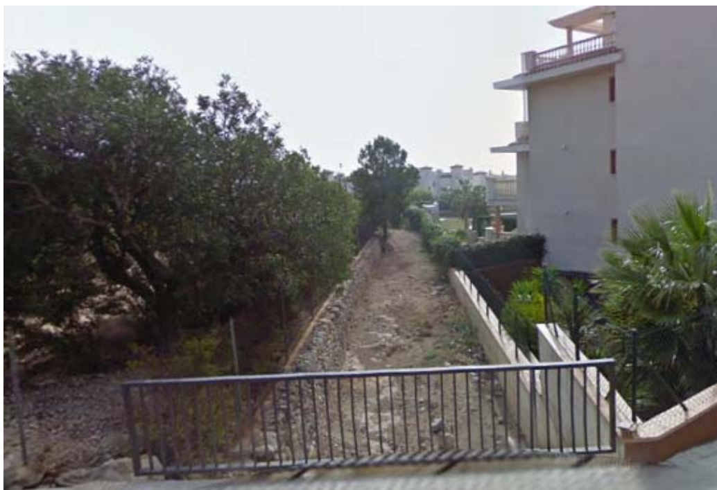
F6. Vista del tram encarrilat del barranc de la Porrassa aigües avall del carrer "A. Poblats d'Hifrensa".
