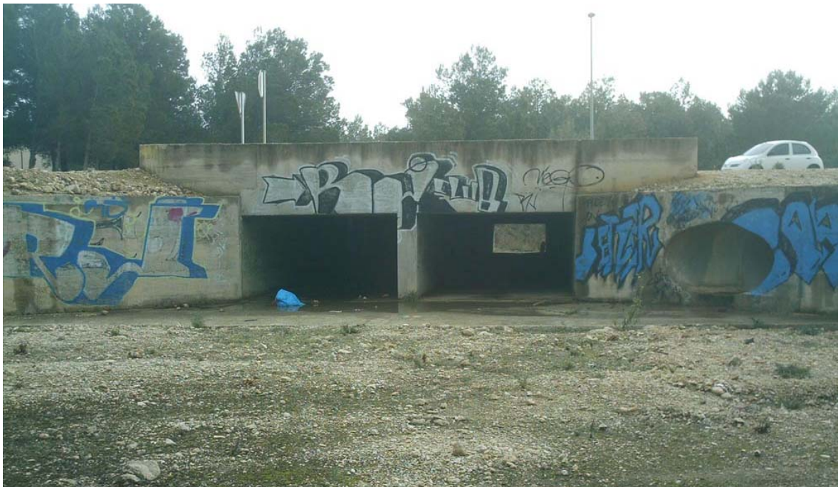
F13. Vista de la bassa existent aigües amunt de la Via Augusta i de l'obra de drenatge del barranc de l'Alcantarilla Gran sota aquesta. Vista des d'aigües amunt cap aigües avall.
