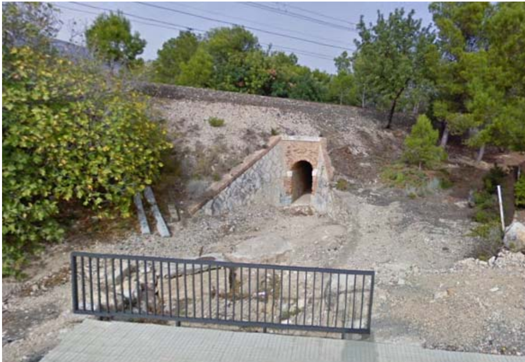
F5. Vista de l'obra de drenatge transversal anterior des del carrer "A. Poblats d'Hifrensa", sota el qual hi ha una obra de drenatge del barranc de la Porrassa.
