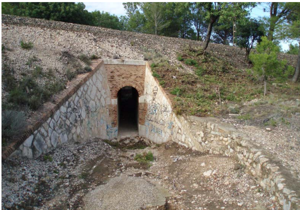
F4. Vista de l'obra de drenatge transversal sota la línia de ferrocarril. Vista des d'aigües avall cap aigües amunt.
