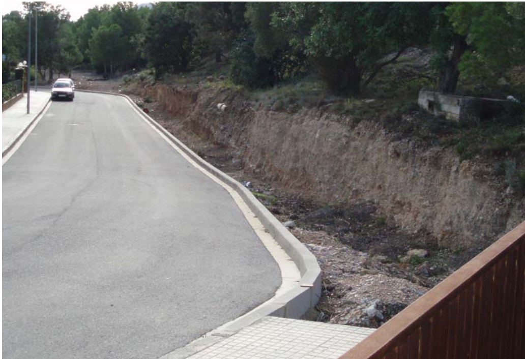
F9. Vista del canal de terres adjacent a la vorera costat muntanya del carrer A Poblat d'Hifrensa . Desviament provisional del barranc de la Porrassa cap el barranc de l'Alcantarilla Gran.
