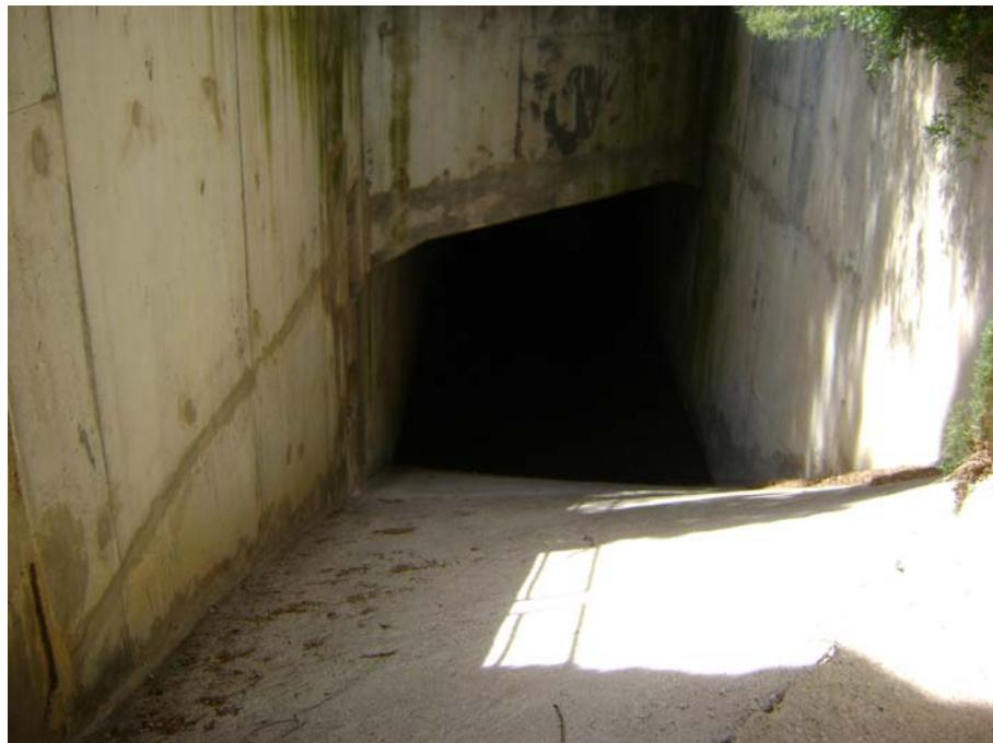
Resalto y pozo de sedimentación a la salida de la galería del ferrocarril y a la entrada del tubo bajo la CNVII
