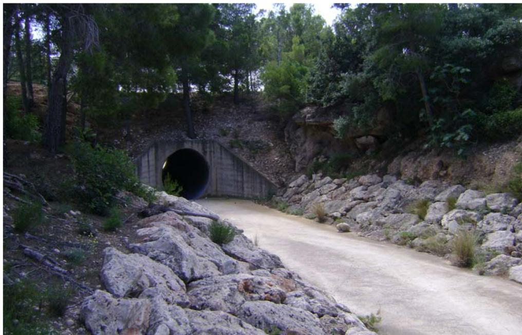
Tubo armco bajo la antigua CN-340 y canal trapezoidal con solera de hormigón y taludes de escollera entre la autopista y el ferrocarril.
