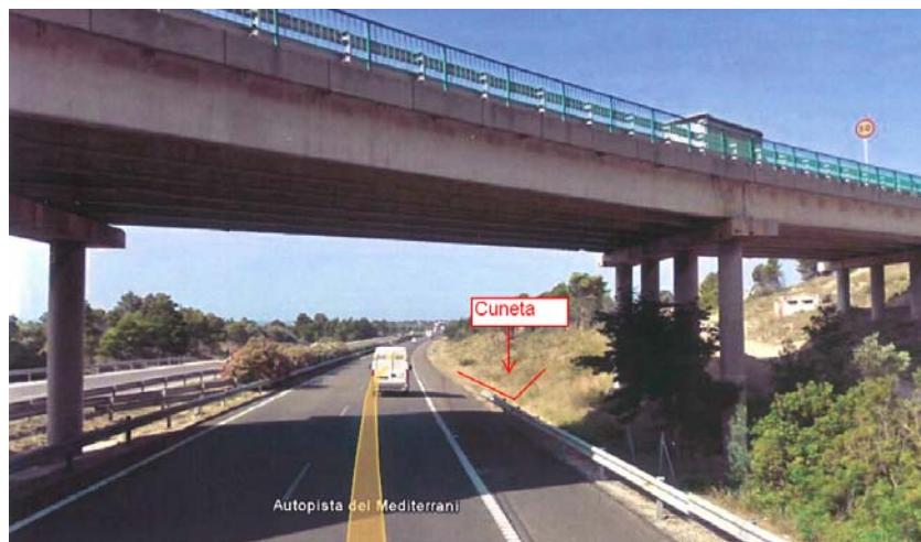
Se procede a calcular el calado alcanzado en la cuneta para evacuar los caudales que no pasan por el cajón de la autopista. La cuneta es de sección triangular con taludes 3H:1V
